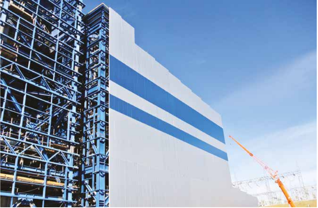
EnerjiSA Tufanbeyli Termik Santral - Adana / Taşıyıcı Çatı ve Cephe Paneli Rockwool Roof and Wall Panels
