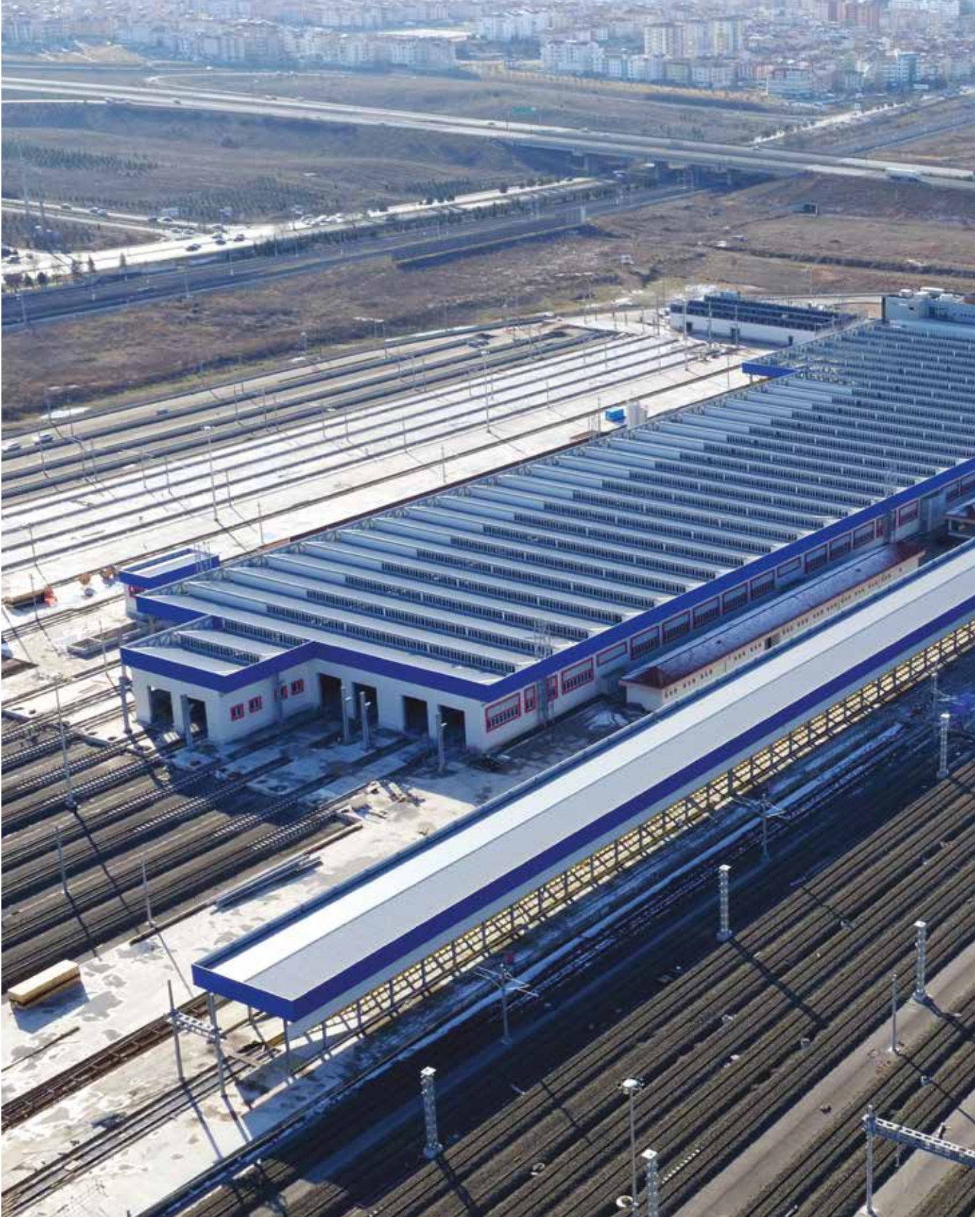
Gülermak - Kolin YHT Gar Kompleksi Projesi Ankara / Taşıyıcı Çatı ve Cephe Paneli Rockwool Roof and Wall Panel
